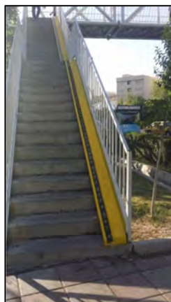
شکل ۸. رمپ فلزی ساخته شده از ورق
