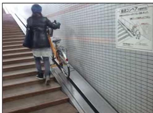
شکل ۷. رمپ فلزی ساخته شده از ورق
