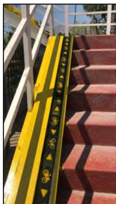
شکل ۱۰. رنگ و شابلون اجرایی روی رمپ
