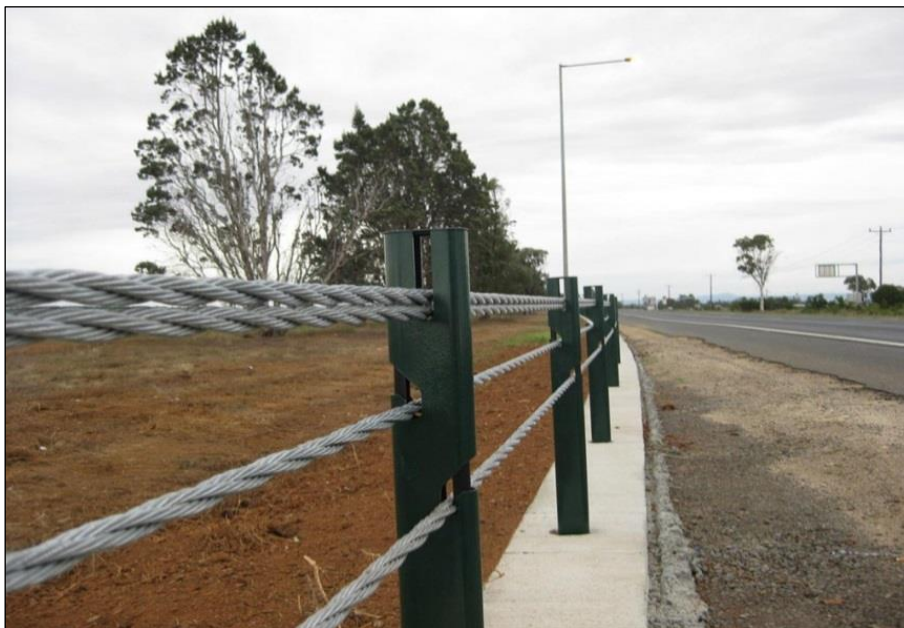
شکل ۲-۳- نمونه‌ای از حفاظ‌های فلزی کابلی
