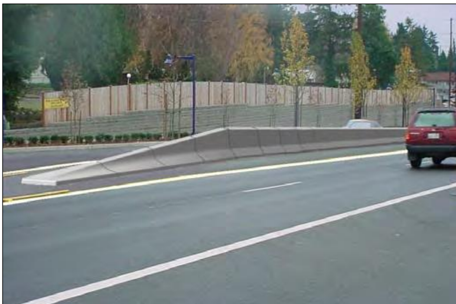
شکل ۵-۲۰- نمونه‌ای از شیب‌دار کردن ابتدای حفاظ بتنی
