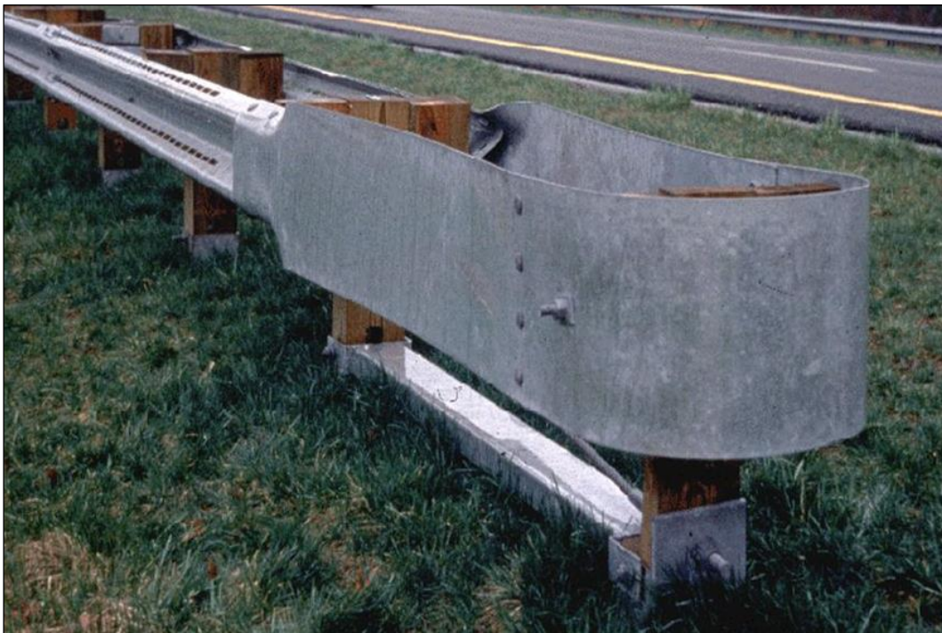
شکل ۶-۲- ضربه‌گیر ابتدایی مستهلک‌کننده
