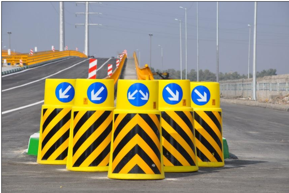
شکل ۶-۷- استفاده از بشکه‌های ماسه به عنوان ضربه‌گیر
