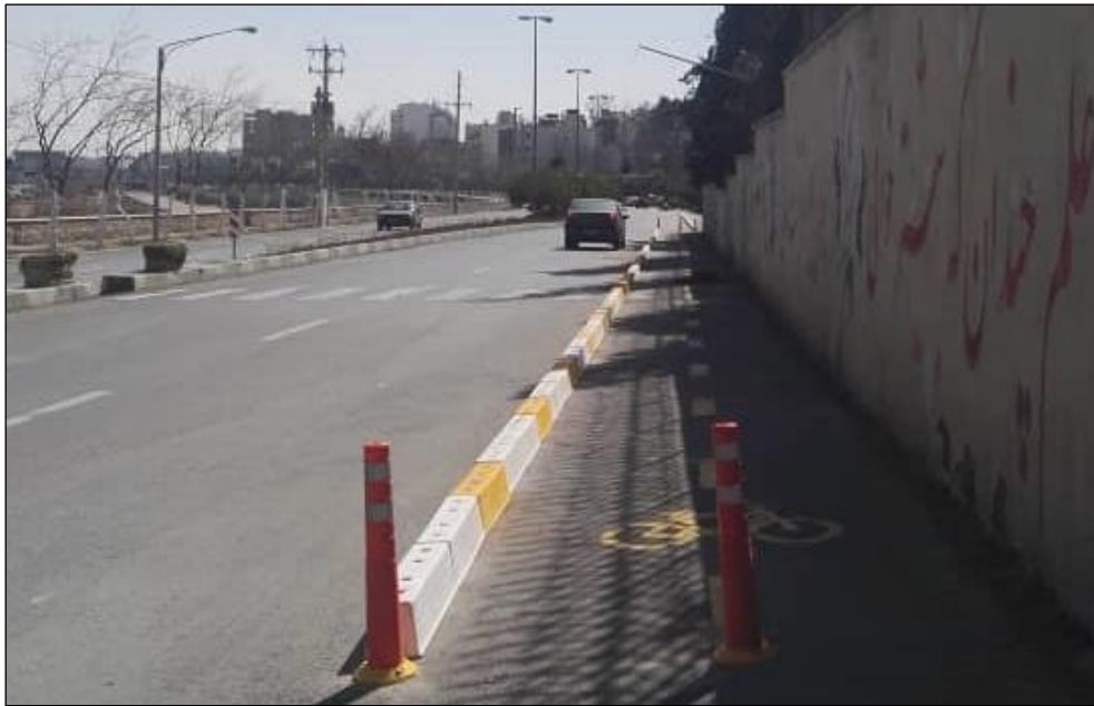
شکل ۴-۸- جداسازی مسیر درجه ۱ از سواره‌رو با استفاده از جدول
