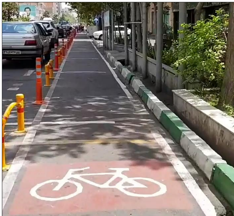
شکل ۴-۷- جداسازی مسیر درجه ۱ از سواره‌رو با استفاده از نرده
